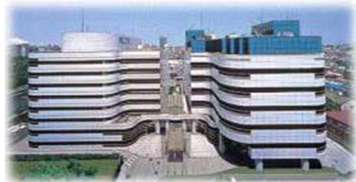
LIXIL東京総合ショールーム
